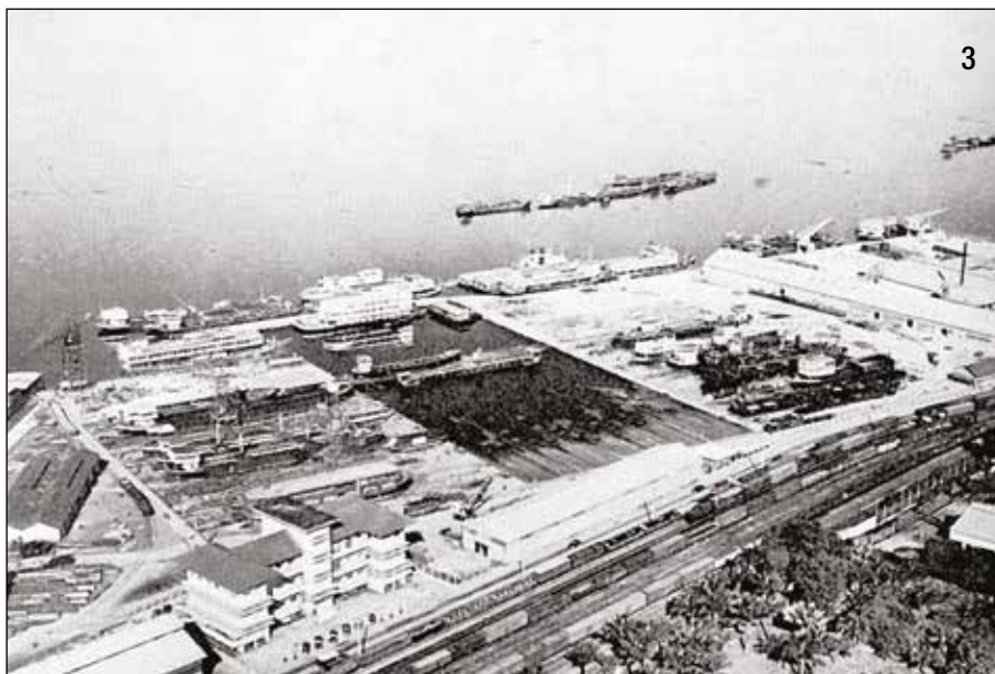
3. Vue aérienne de l'impressionnant chantier naval de l'Otraco à Léopoldville. Photo Otraco Rail au Congo belge
