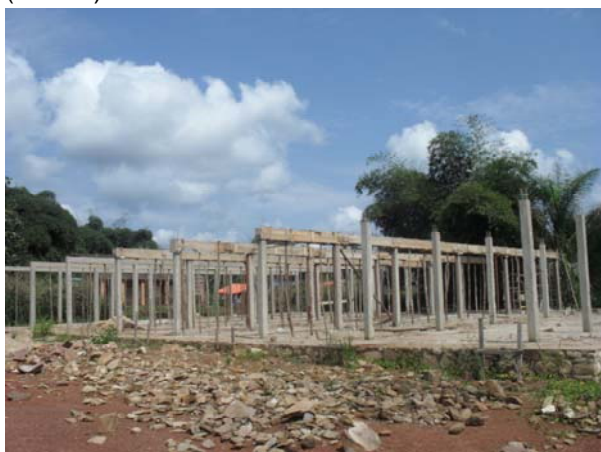
Marché moderne en construction à Ubundu
